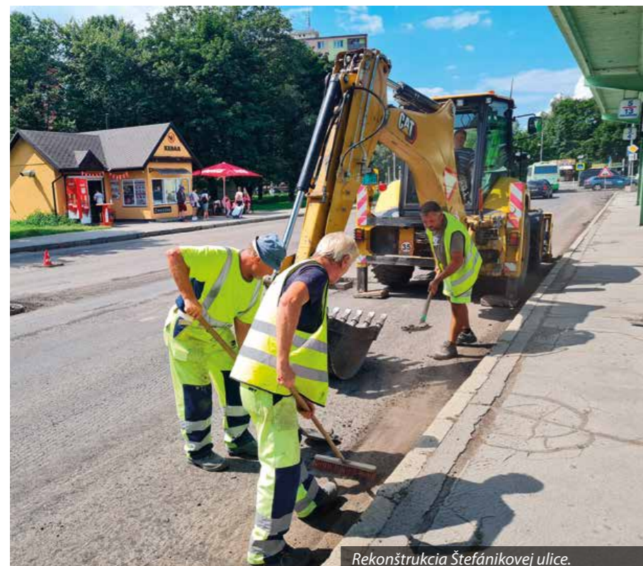
Rekonštrukcia Štefánikovej ulice.
